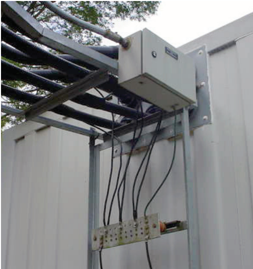
Fig. 9.21 – Aterramento da blindagem de cabos coaxiais.
