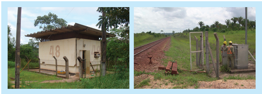
Fig.10.22 – Abrigo típico utilizado para equipamentos de sinalização e bastidor Case.
