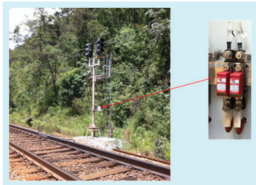
Fig.10.33 – DPS instalado na caixa de junção junto ao poste do sinaleiro.
